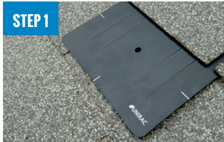
INSTALL FLASHKIT PRO FLASHING
